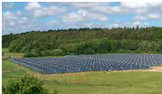
SOLFÅNGARANLÄGGNING I KUNGÄLV Sveriges största solfångaranläggning med sammanlagt 10 000 m 2 solfångaryta från Effecta. Anläggningen har varit i drift sedan 1999 och producerar ca. 5 000 000 kWh/år.
