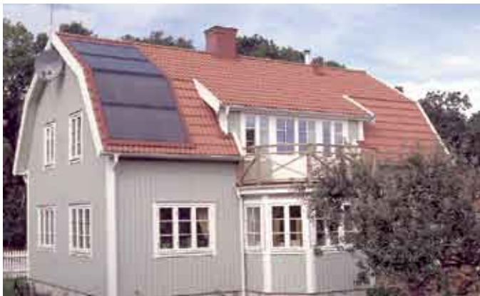
Plana solfångare i nedfällt montage.
