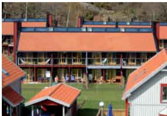
LINDÅS PARK I KUNGSBACKA KOMMUN Sveriges första "nollenergihus" vilket innebär att det inte finns något aktivt uppvärmningssystem förutom ST solfångare från Effecta AB. Sedan 1999 har hushållsmaskiner, energin från de boende och vår solfångaranläggning effektivt tagit hand om husets värmebehov.
